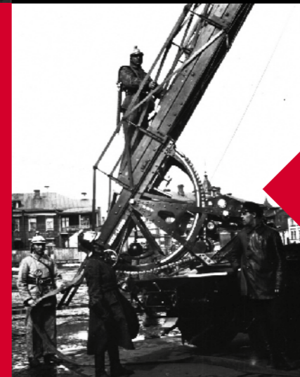
Автолестница К-30 в работе. Москва, Сокольники
